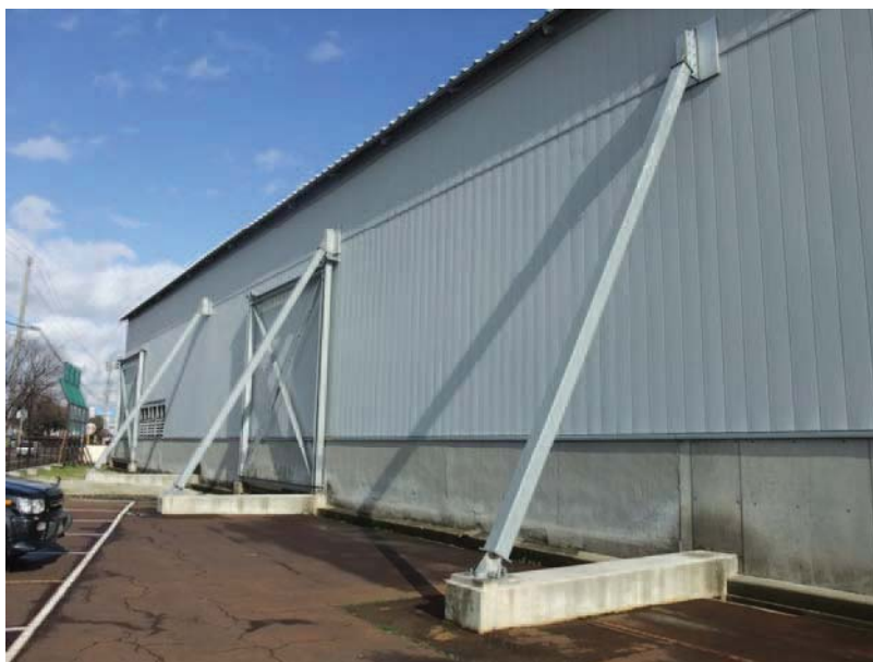
【地震後に工場側面に取り付けた補強】
